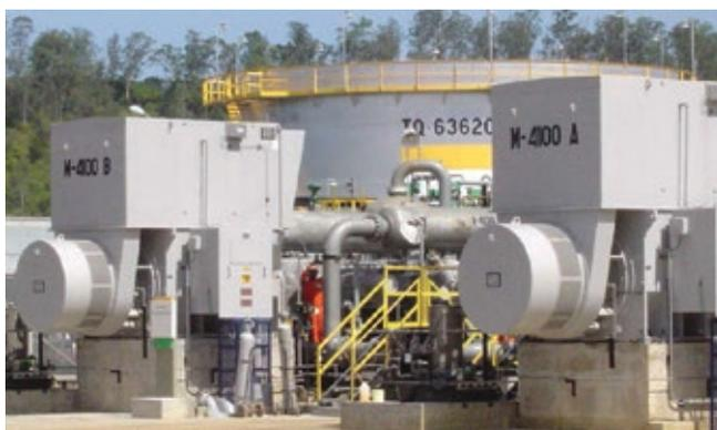
Motores sincrónicos SEF900 (Ex-p), 3.600 kW, 13.200 V
