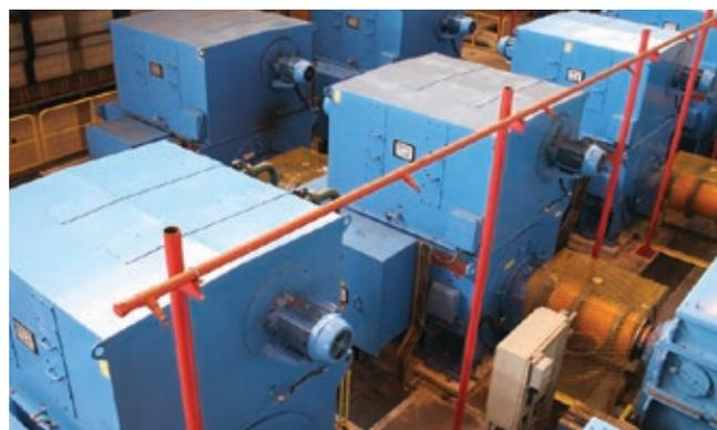
Motores sincrónicos SDL800, 3.000 kW, 3.100 V
